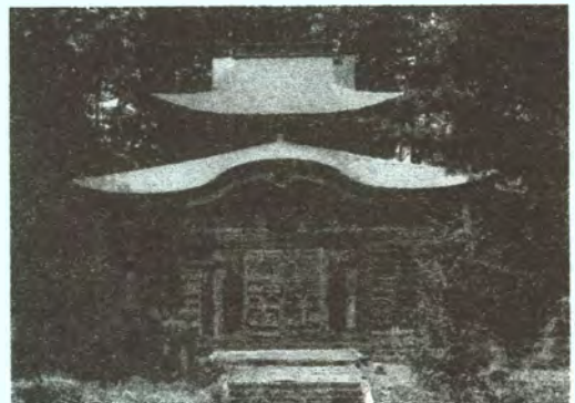
金峯神社本殿 中世藤原氏の棟札が残ります。入母屋造、銅板葺の建物です。(写真 鶴岡市教委)
